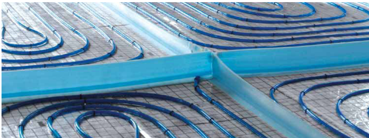
14. Ábra Fűtőmezők dilatációs hézagokkal való felosztása
